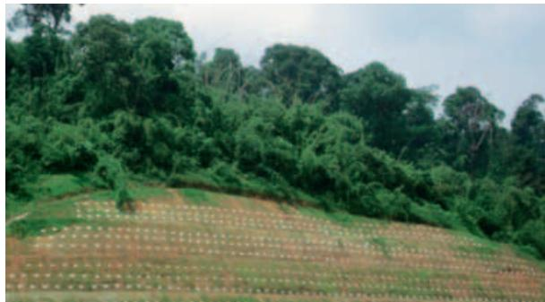
Pemakuan tanah digunakan untuk menstabilkan tanah dan mencegah tanah runtuh di tapak-tapak projek kami
