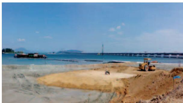
Permatang pasir dibina di sepanjang pengisian tanah untuk mencegah pencemaran laut semasa penelusuran tanah
