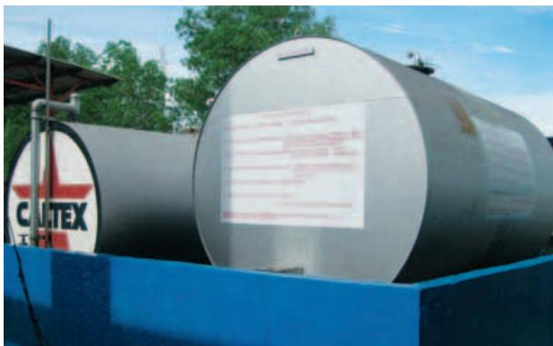
Tangki skid ditutup dengan dinding konkrit perimeter untuk mencegah tumpahan minyak di kilang-kilang dan kawasan sekitar di bawah keperluan OSHA 1994
