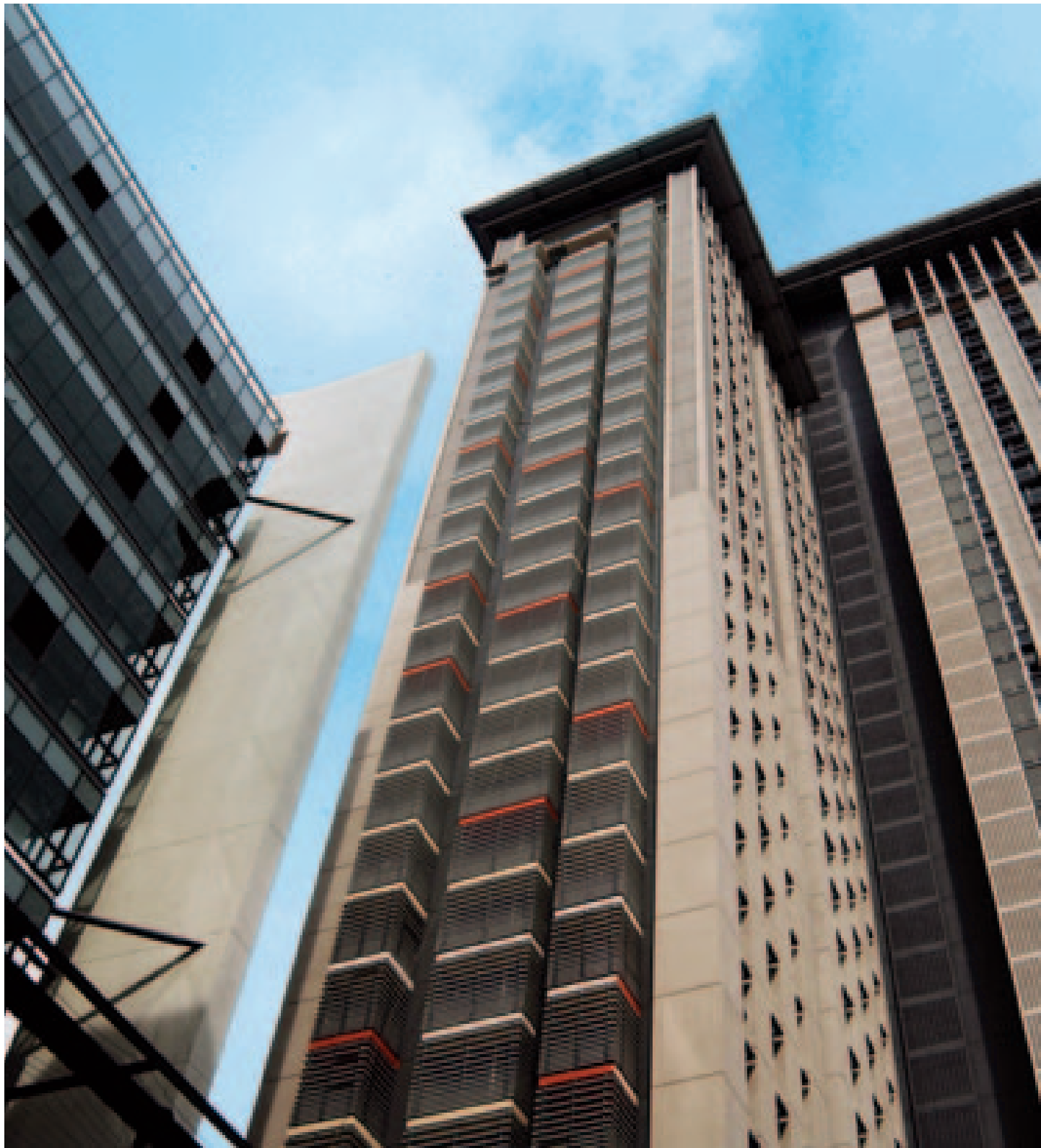
Pembangunan PJ8 terdiri daripada pejabat-pejabat komersial dan apartmen perkhidmatan di Petaling Jaya, Selangor
