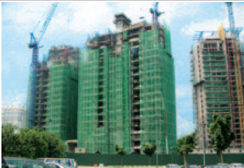
Keselamatan: Penggunaan perancah dan jaring di tapak projek
