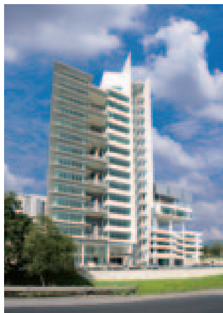
Menara IJM Land, Pulau Pinang
