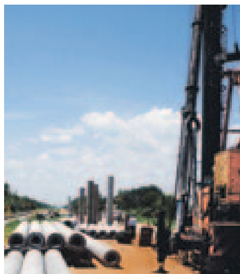
Projek Landasan Kereta Api Elektrik Berkembar Bahagian Utara
