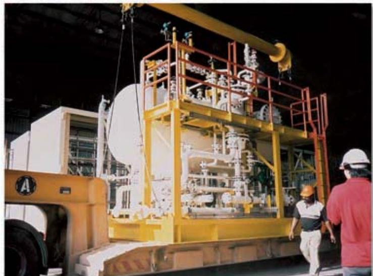
Peletakan muatan 'Produced Water Package' untuk Offshore Process Module
